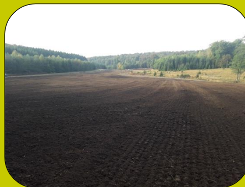
Raclage des résidus de broyage dans la zone humide de l'Illé (à gauche), et restauration d'un ensemble de près de 4 ha à la Fagne du Haut du Hêtre (Thibessart, à droite).
