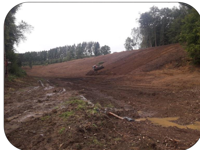
Raclage de l'horizon organique du versant de la petite Vaux (Meix-devant-Virton) à l'aide d'une machine adaptée à la forte pente.
