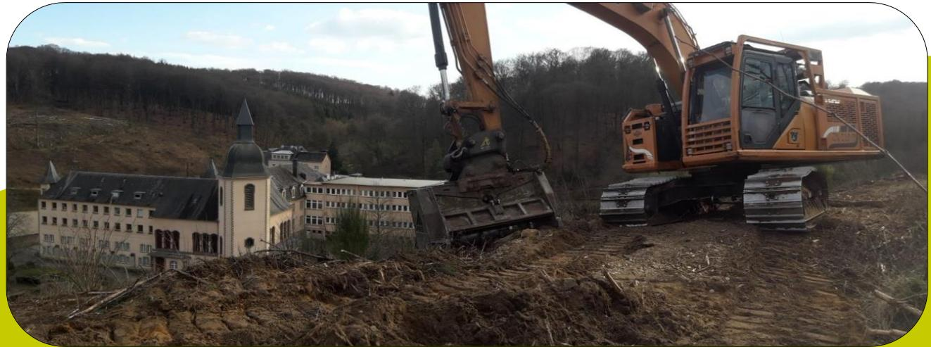
Broyage de surface à la pelle mécanique dans les pentes les plus importantes du site (mars 2019)
